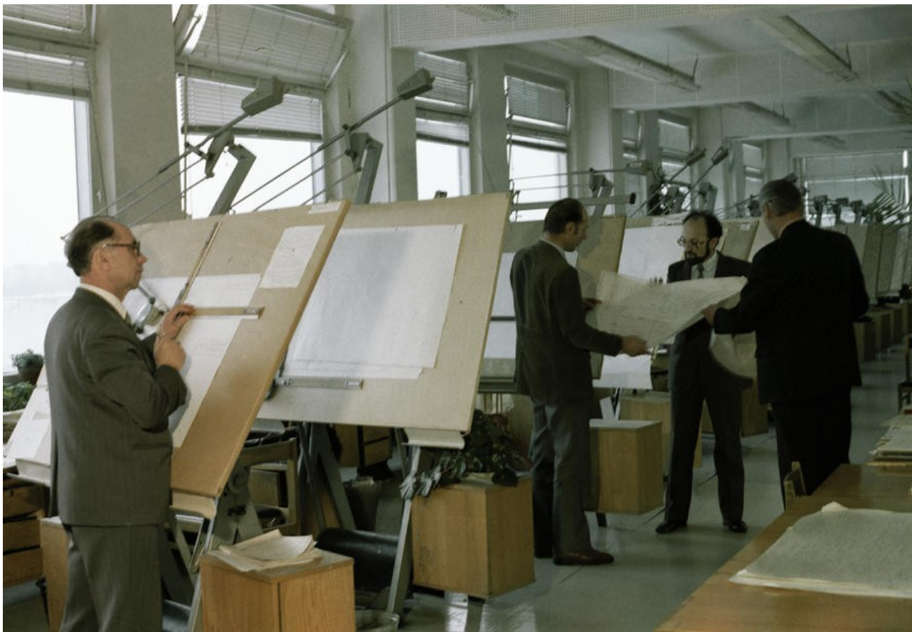
Рисунок 2.10 — Типичное использование кульмана в конструкторском бюро (Интернет)
